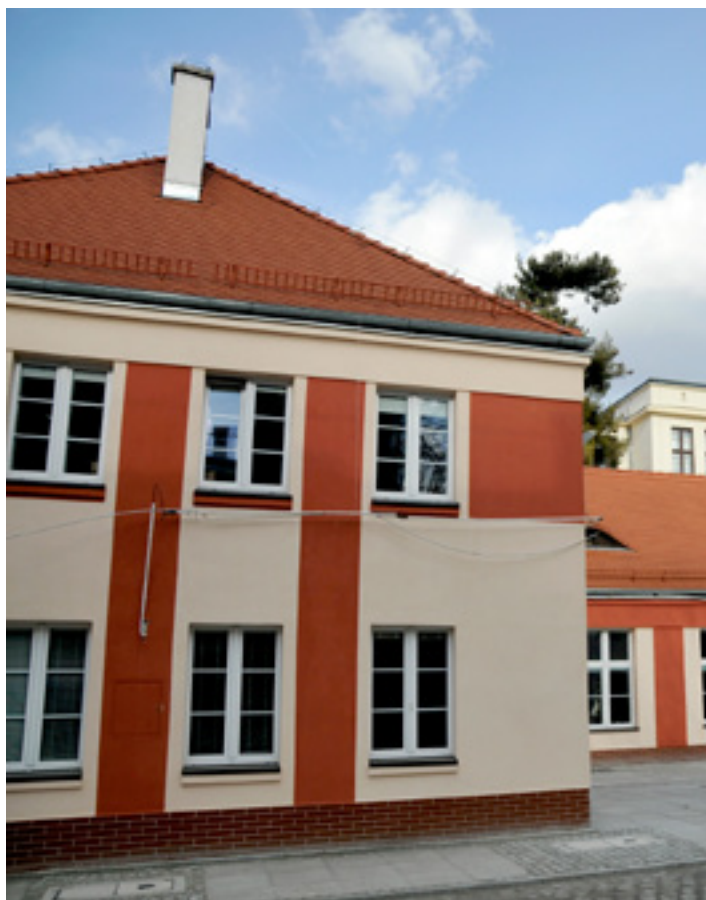
▲ Nowa elewacja budynku Biblioteki Głównej
