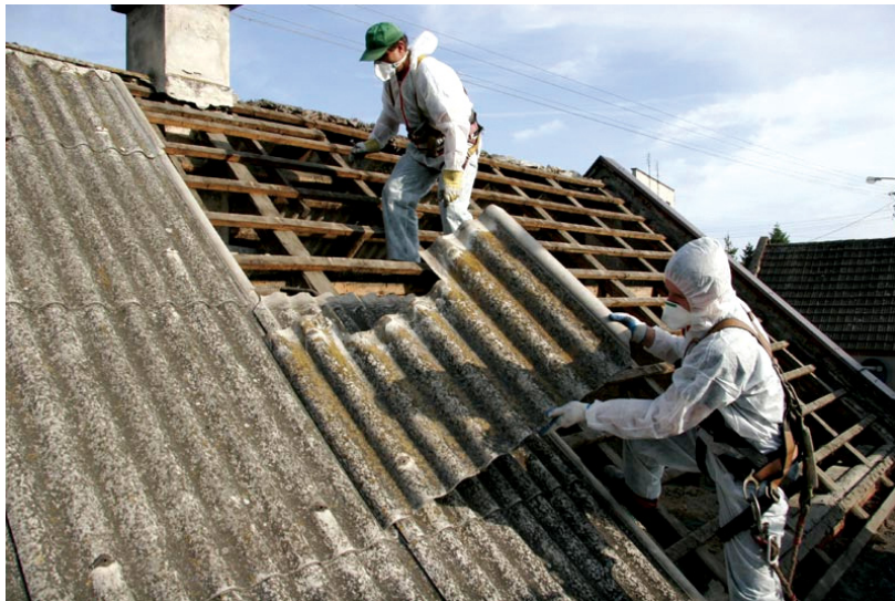
Ryc. 2. Pracownicy demontujący wyroby azbestowe z dachu
