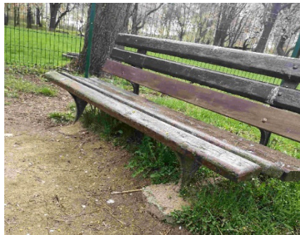
Rys. 6. Wystający fundament na placu nr 5
