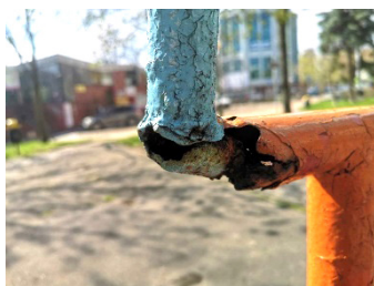
Rys. 4. Ostry, zardzewiały element na placu nr 3
